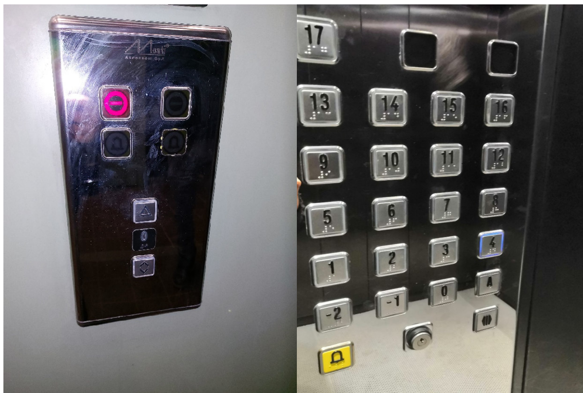
Figura 8: Esempio di bottoniera esterna di piano (sinistra) e interna di cabina (destra)
