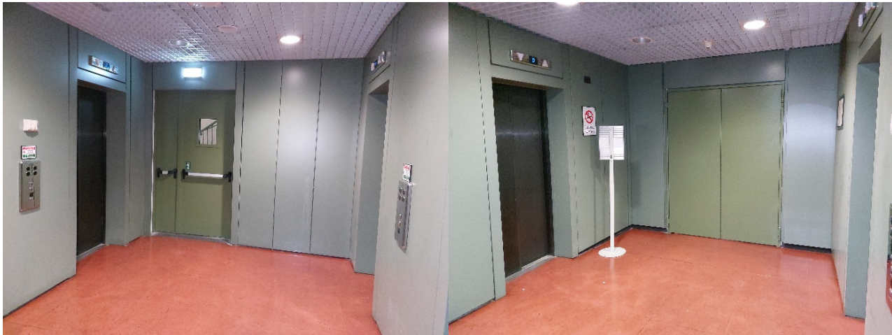
Figura 9: Immagini raffiguranti l'area di sbarco del blocco ascensori n. 3-4-5-6 (primo piano) da adibire ad area di cantiere.
